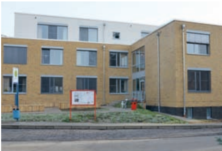
Der Altbau hat ausgedient: DRK-Einrichtung im neuen Gewand.
